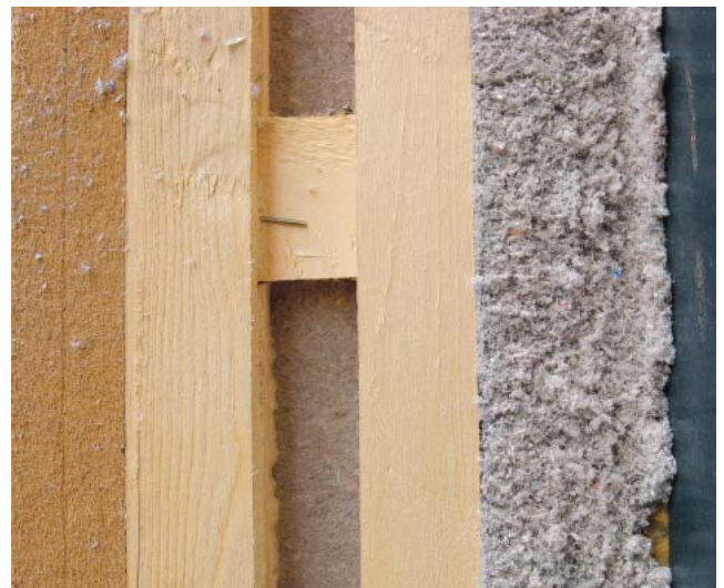
Die Fassade im Schnitt mit passgenauer isofloc-Dämmung.
